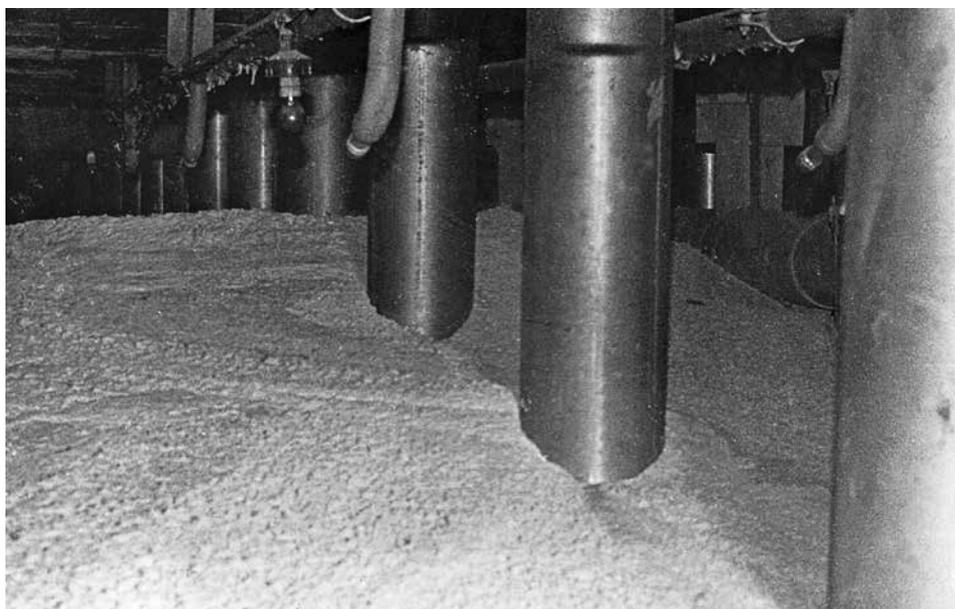
*Наплывы «свежего» бетона на первом этаже бассейна-барботёра*
