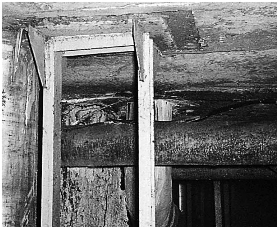
*Поврежденные расплавом ядерного топлива металлические конструкции*
