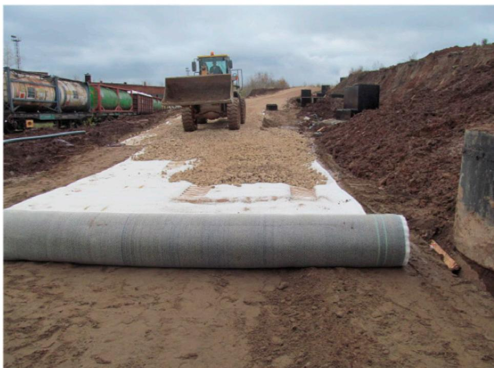
Рисунок 8. Работы по устройству многофункционального защитного покрытия [25]
